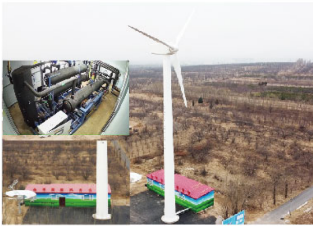
中科院风力氨热泵项目
