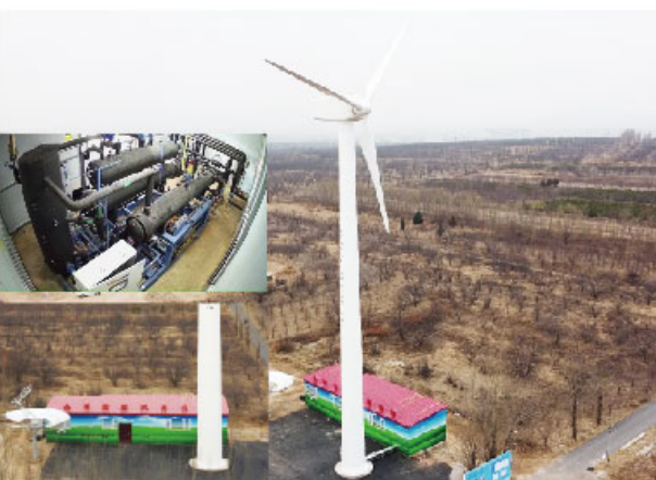
中科院风力氨热泵项目
